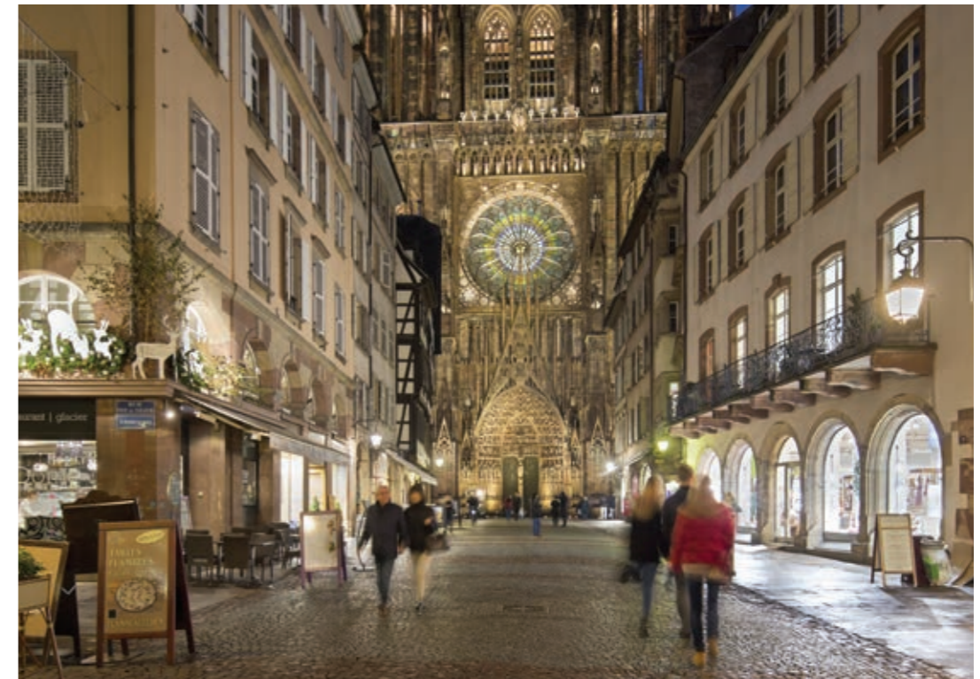
L'éclairage de la cathédrale a requis l'utilisation de plus de 400 projecteurs LED.
