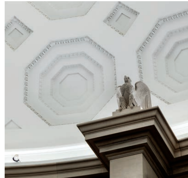
Les spots LED dissimulés le long de la corniche à la base de la voûte illuminent les grandes compositions picturales de la rotonde.
