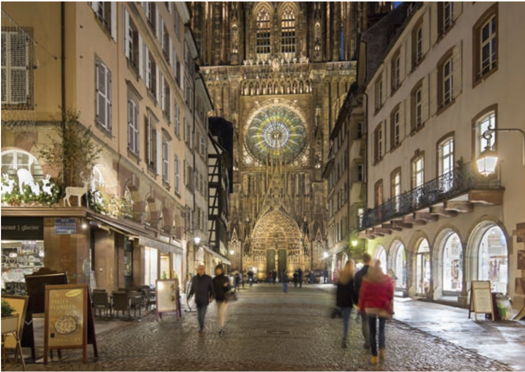
Oltre 400 proiettori a tecnologia LED costituiscono il nuovo impianto d'illuminazione della Cattedrale.
