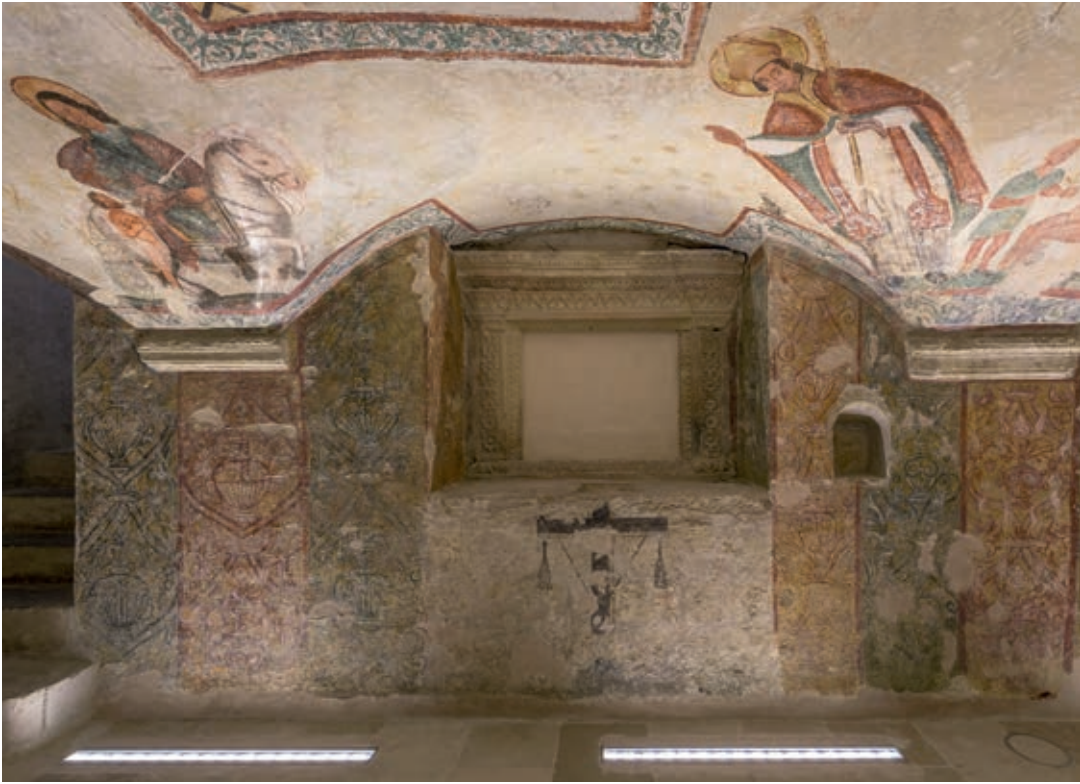
Gli antichi affreschi della Cripta illuminati da apparecchi incassati a terra con ottica wallwasher e schermatura delle sorgenti LED.
