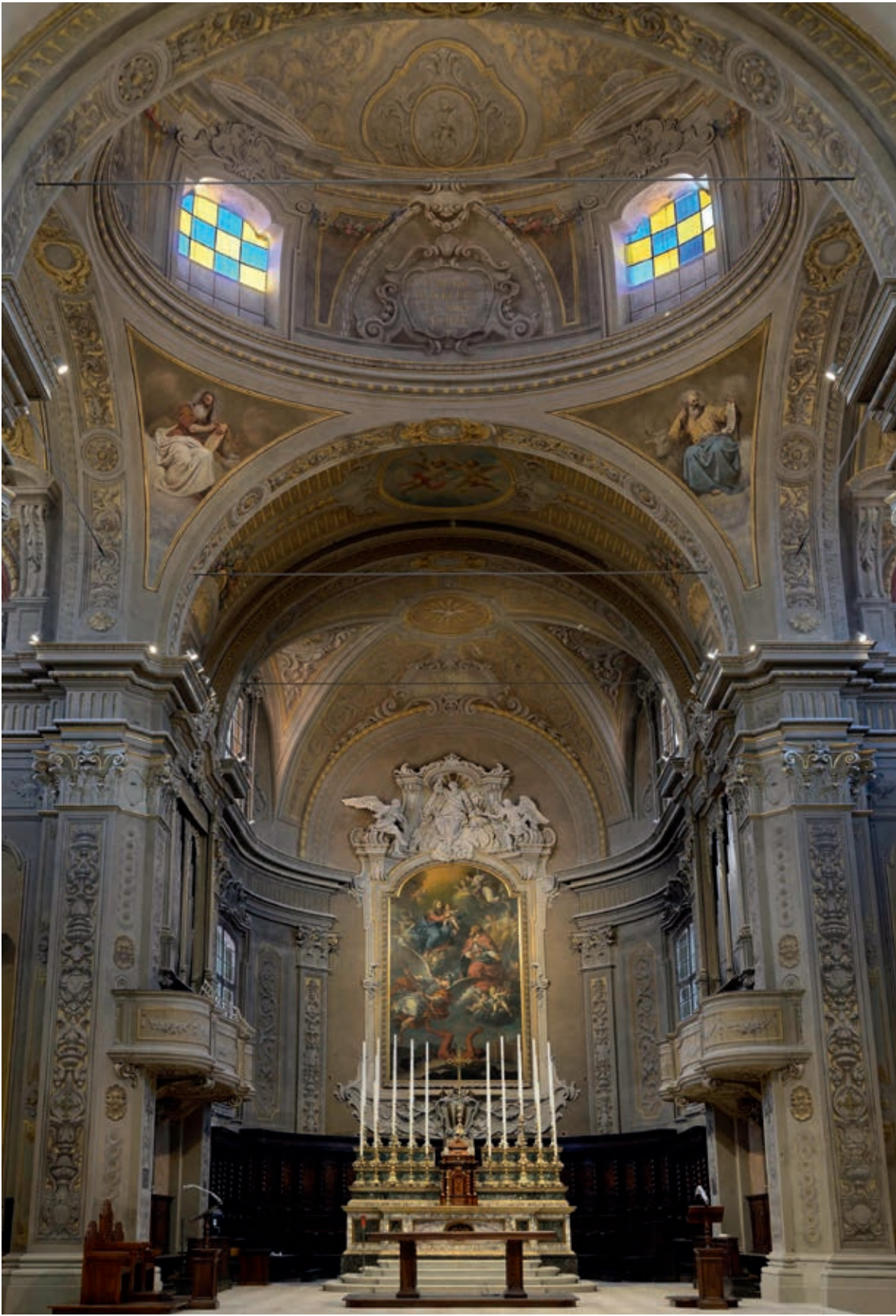
Grazie a finiture tono su tono e al posizionamento a grande altezza dal suolo, i corpi illuminanti scompaiono discretamente alla vista di fedeli e turisti.
