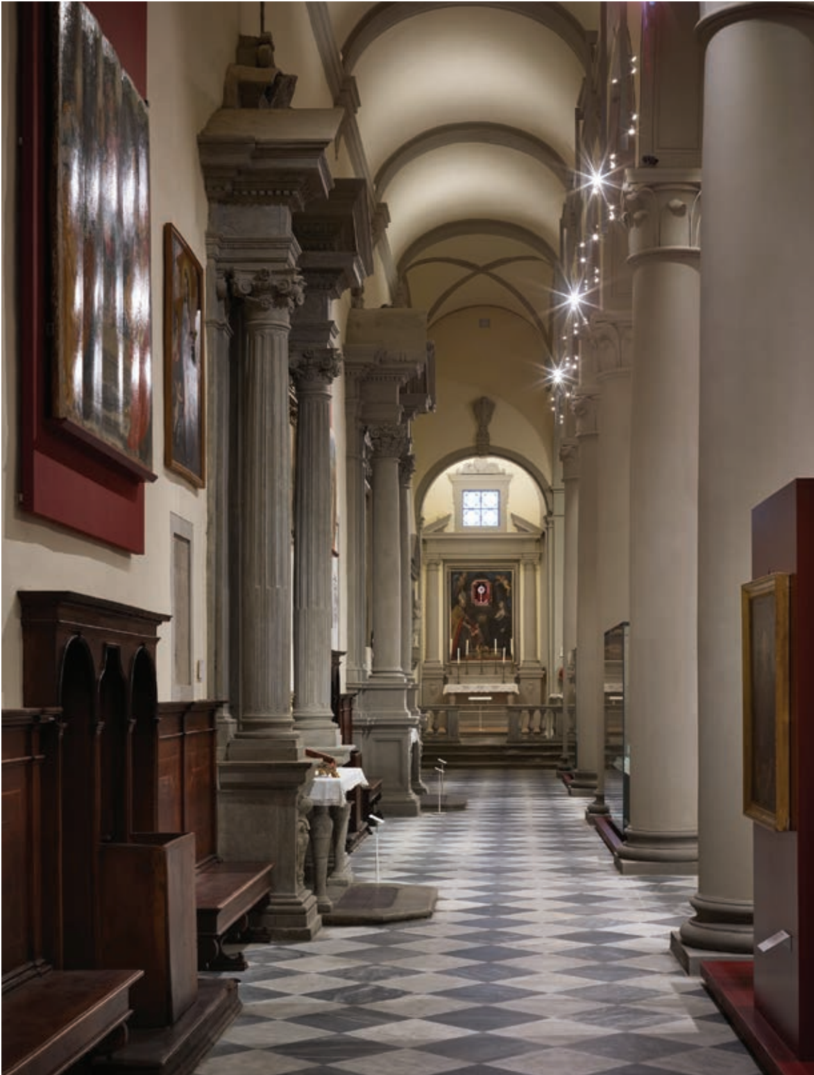
Gli steli lineari a sospensione realizzati ad hoc per il progetto sono posizionati fra le colonne che separano la navata centrale da quelle laterali.
