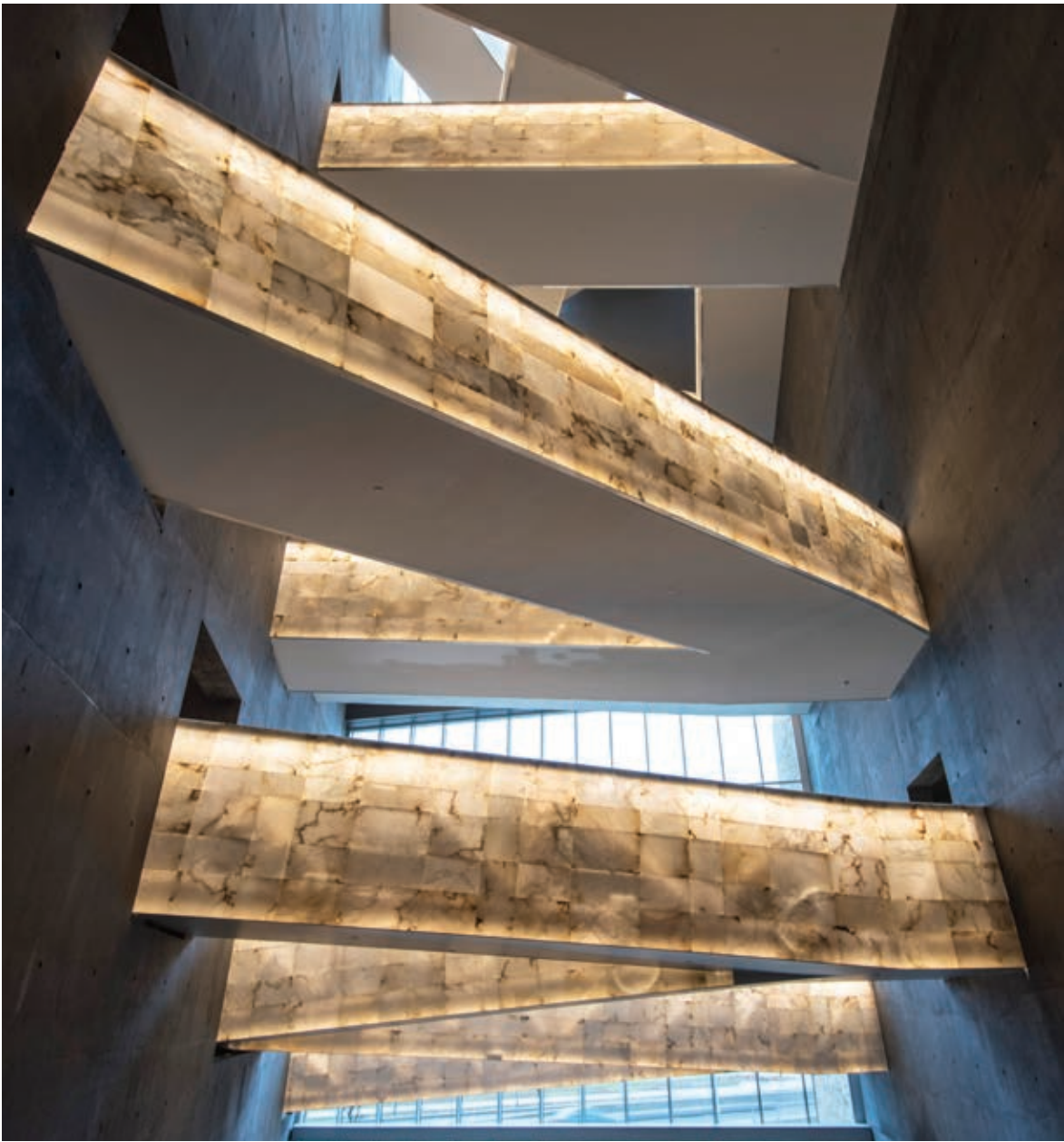
Apparecchi ultracompatti sono inseriti nell'intercapedine fra la struttura e l'alabastro a esaltarne la trasparenza.
