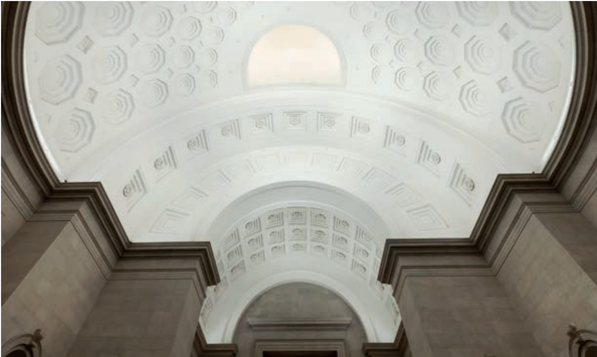
Il nuovo impianto di illuminazione con sistema di controllo digitale della luce ha ridotto di oltre l'80% i consumi di energia.
