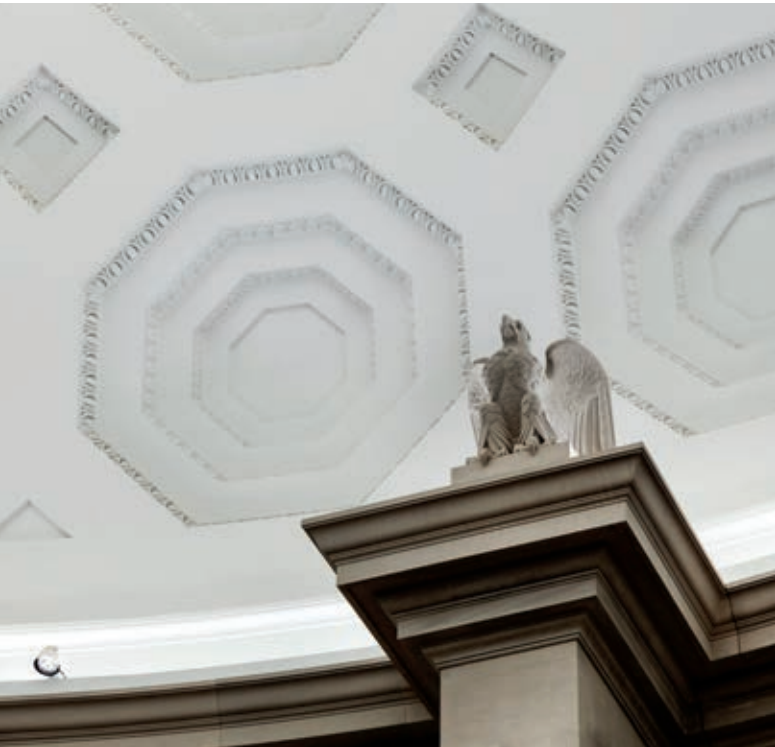
Proiettori a LED posizionati a scomparsa lungo la cornice alla base della volta illuminano le grandi composizioni pittoriche della Rotonda.
